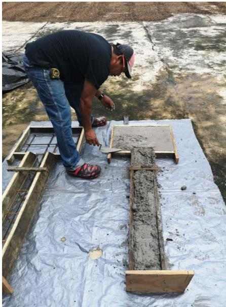
Figura 19. Llenado de las formaletas con material de construcción.
