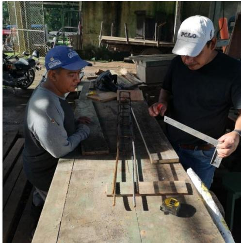
Figura 16. Albañil y trabajador de campo formando las columnas de hierro.
