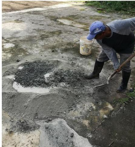
Figura 18. Trabajador de campo realizando la mezcla de cemento para la fundición de los rótulos.
