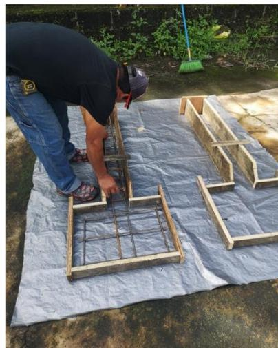
Figura 17. Realización de las formaletas previo a la fundición.
