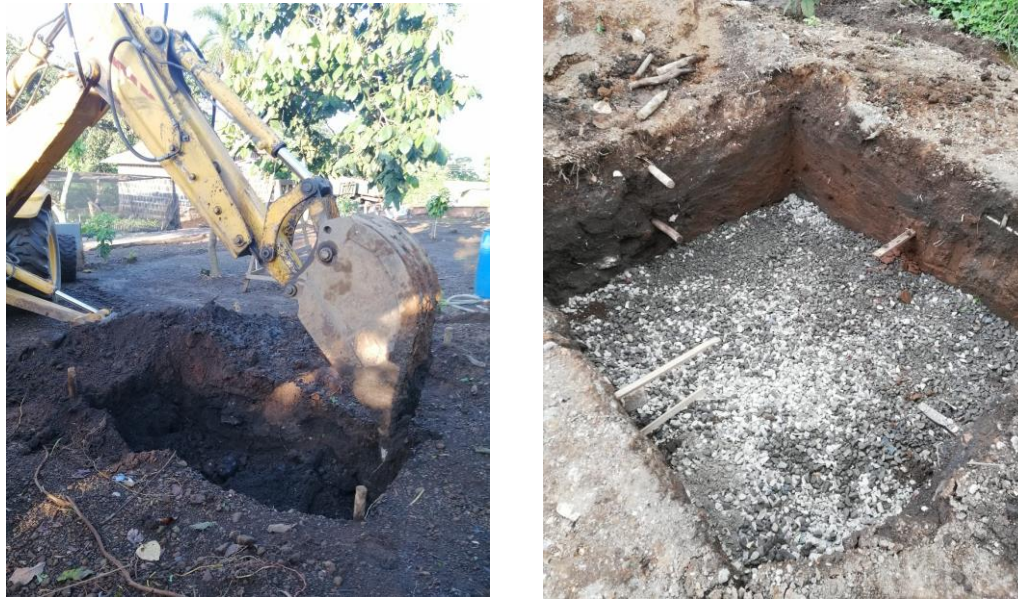
Figura 16: Excavación del agujero y delimitación del piedrín.
