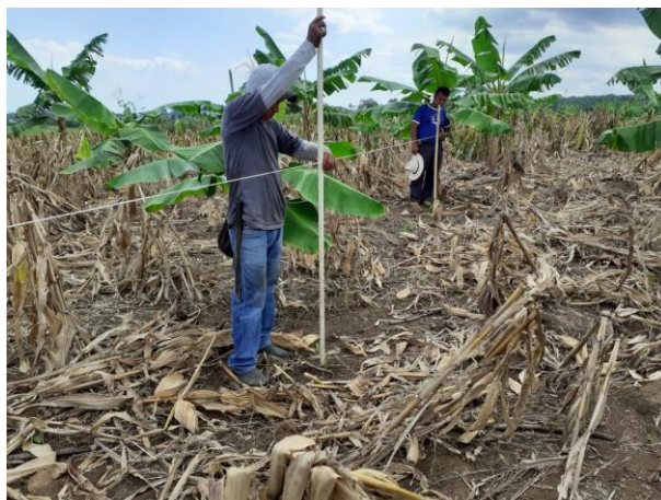
Figura 7: Establecimiento de estaca del trazado.
