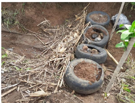
Figura 17: Resistencia de barrera muerta establecida dentro de la cárcava.
