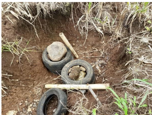
Figura 16: Reparación de barrera dañada por la lluvia.
