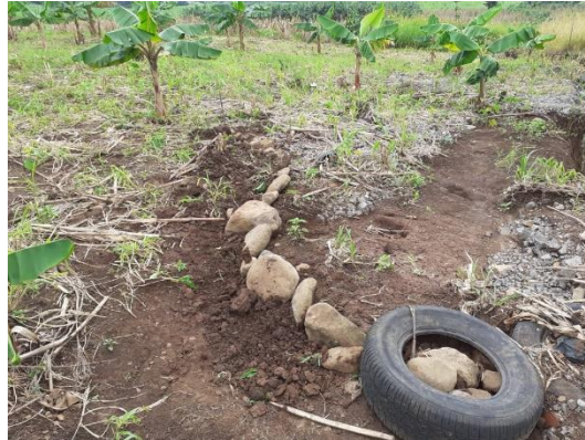
Figura 19: 8 metros lineales de curva a nivel realizado.
