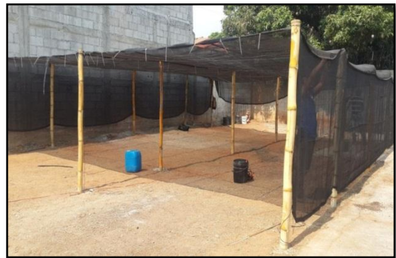
Fotografía 2. Posteo y colocación de sarán para la implementación de los modelos de composteras domiciliarias y métodos de compostaje.
