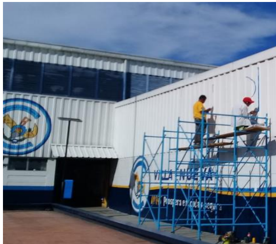
Imagen No. 11 Análisis estructural Mercado Villa Nueva
