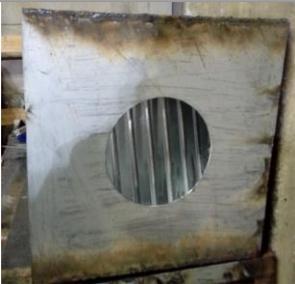
Una fotografía que muestra una vista superior (planta) de un componente del economizador. Se trata de una placa rectangular de metal con un agujero circular en el centro. A través del agujero se ven las espirales de las bobinas de serpentín. |
