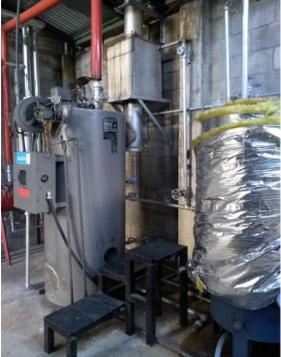
Una fotografía que muestra el economizador instalado en un entorno industrial. El equipo es un cilindro vertical de metal con tuberías y válvulas conectadas. Está situado en un espacio con otros equipos y estructuras de acero.              |
