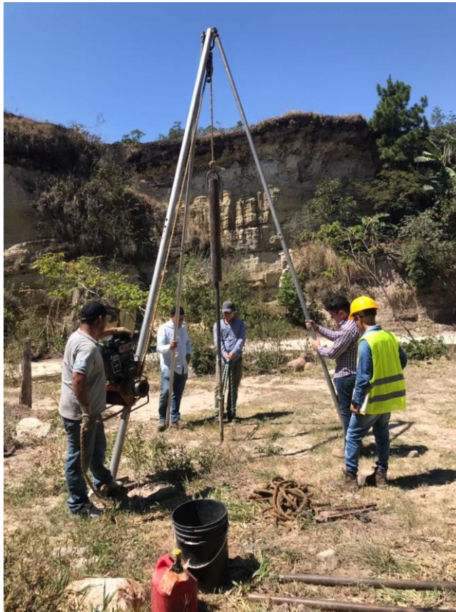
Figura 4. Penetración del muestreador en el suelo
