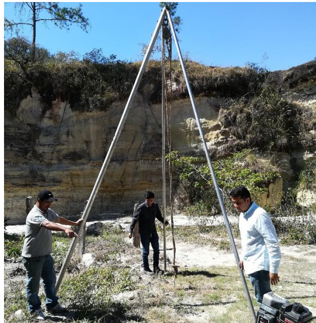
Figura 2. Colocación de equipo
