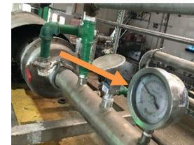
5. Abra la válvula de condensado para drenar toda el agua que haya quedado en el sistema de alimentación de vapor.
