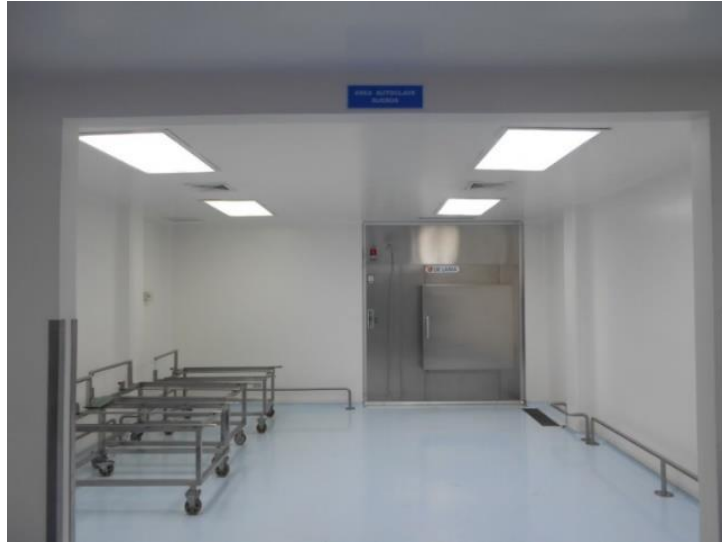
Figura 10. Área de recepción de materia prima
