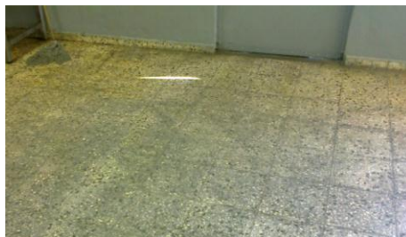
Figura 30. Piso de la empresa
