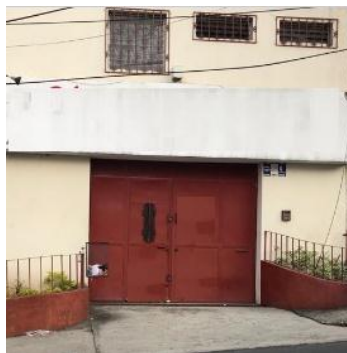
Figura 55. Muelle de carga
