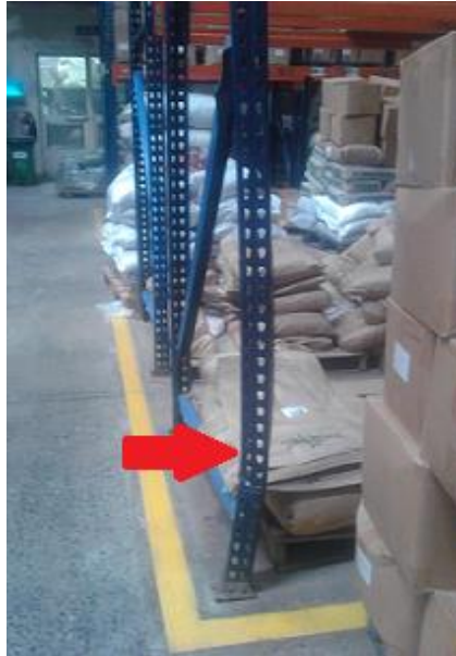
Figura 7. Ejemplo de daño en estructura de estante
