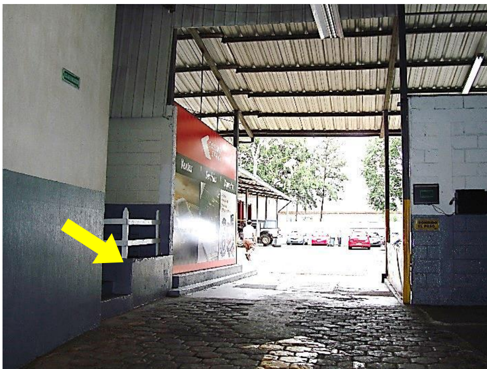
Figura 13. Paso vehicular, acceso al área de torno (indicado con la flecha)
