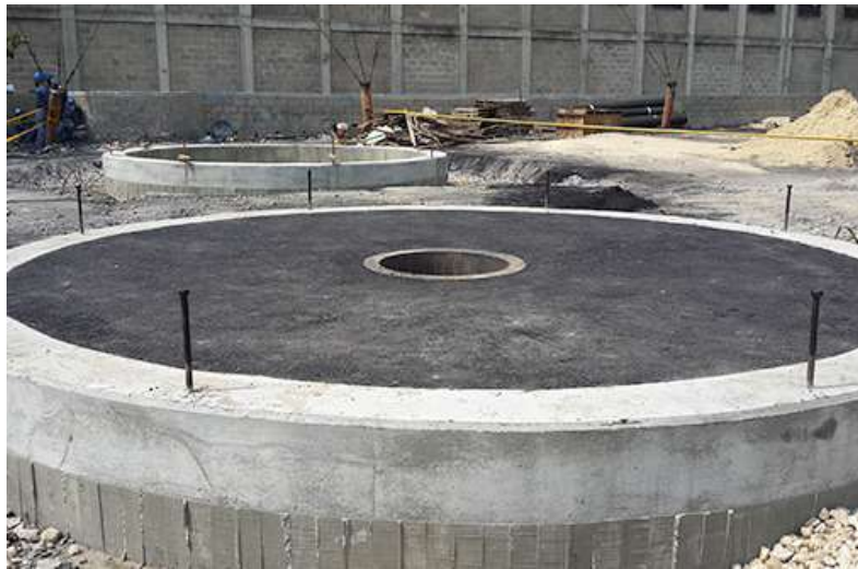
Figura 25. Cimentación anular del tanque
