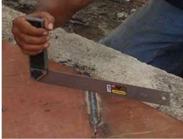
Figura 28. Soldadura de orilla del fondo
