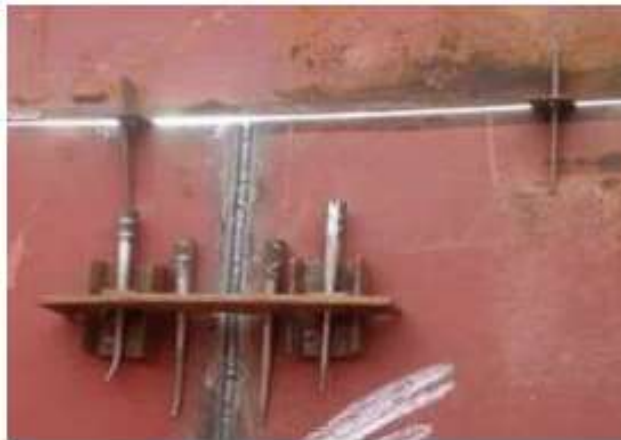
Figura 30. Espaciadores para soldadura
