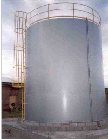
Figura 15. Tanque vertical con escalera vertical
