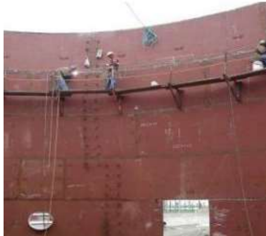
Figura 31. Soldadura interna del cuerpo
