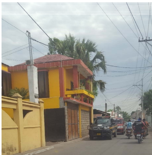
Figura 3. Viviendas en el centro de la aldea
