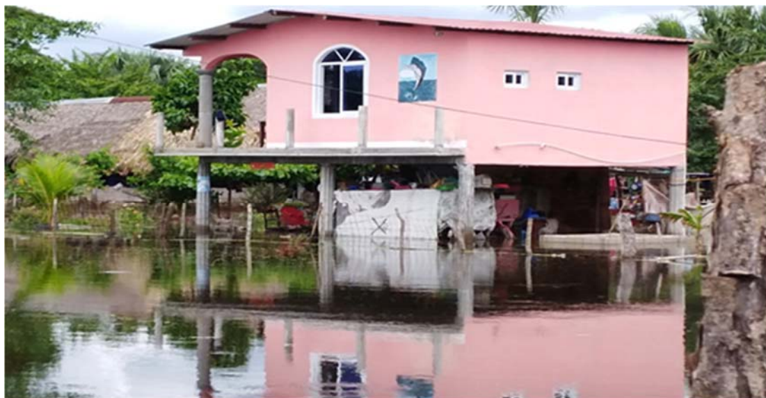
Figura 26. Pérdidas causadas por inundación
