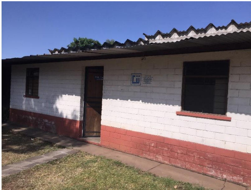
Figura 6. Área disponible para instalación de planta piloto
