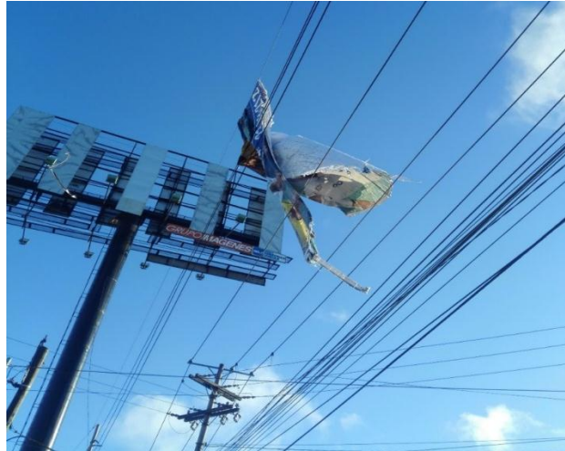
Figura 62. Manta vinílica sobre línea de transmisión
