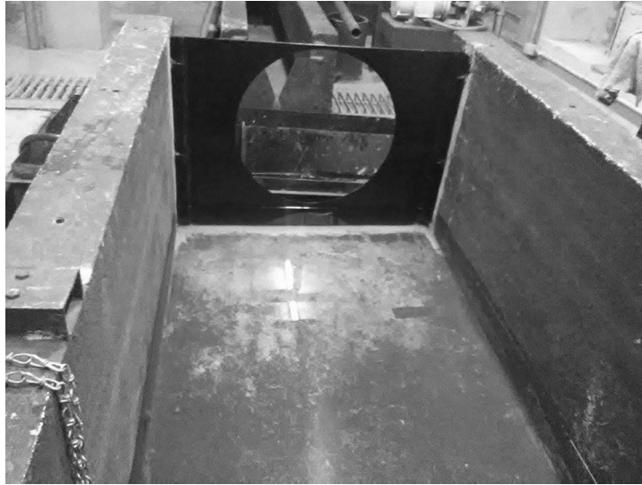
Figura 32. Vertedero instalado con la pared perpendicular a la corriente y bordes impermeabilizados
