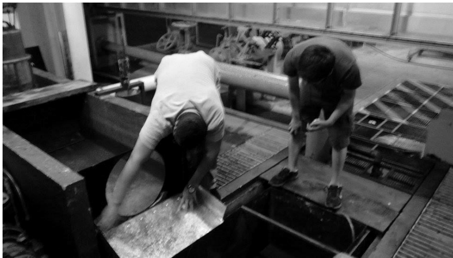
Figura 31. Instalación de vertedero
