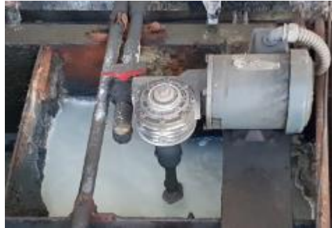
Figura 34. Reactor CSTR de coagulación
