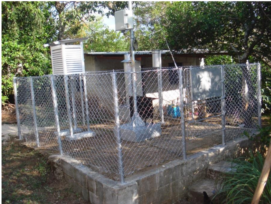
Figura 9. Estación La Pampa
