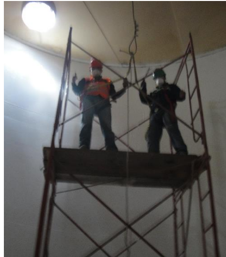
Figura 10. Pintura aplicada con rodillo
