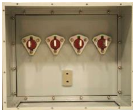
Figura 9. Conexión de potencia (X1-X2-X3-X4)
