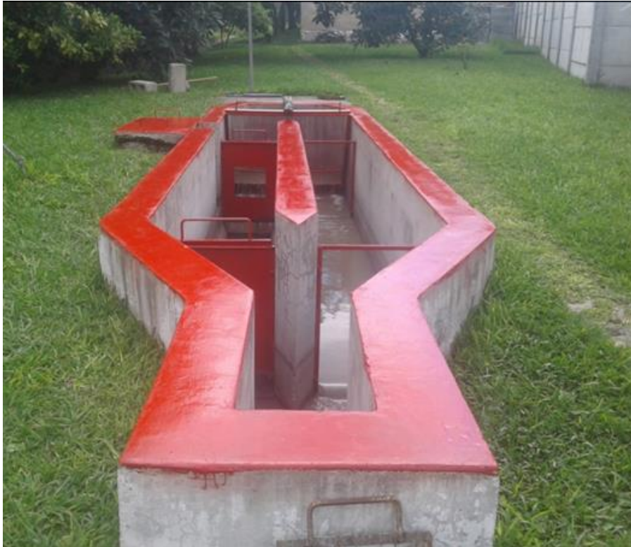
Figura 18. Canal desarenador de flujo constante
