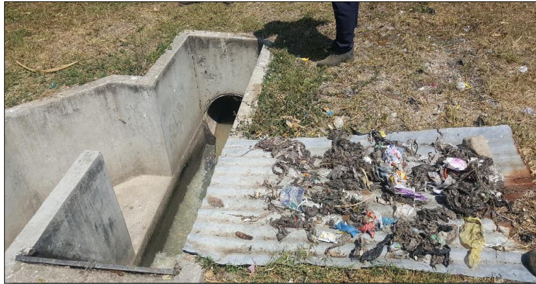
Figura 63. Sólidos extraídos de las rejillas del canal desarenador
