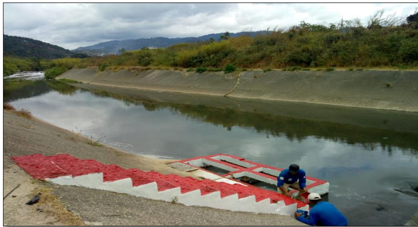
Figura 44. Dique construido para captar el caudal del río Villalobos
