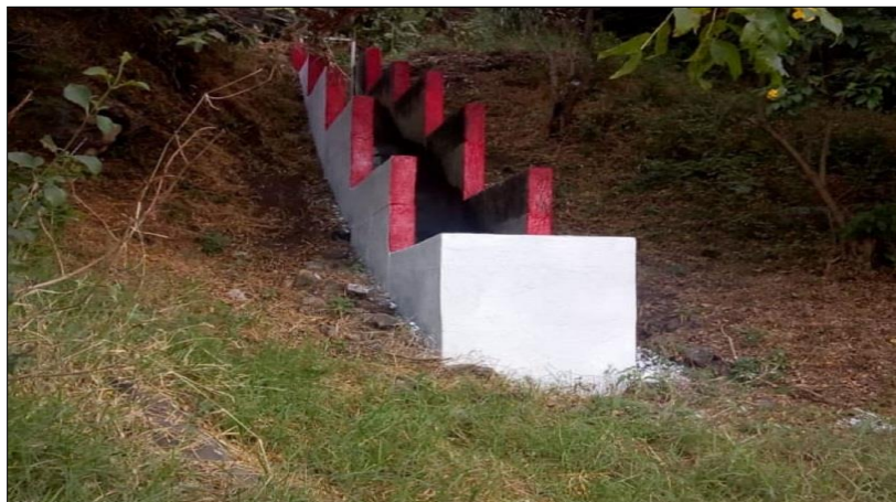
Figura 45. Disipador, aireador de cascada
