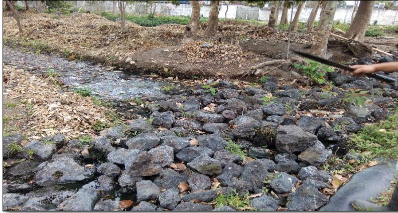
Figura 53. Filtro percolador en humedal artificial
