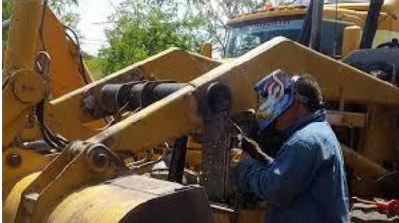
Figura 38. Fisura por fatiga
