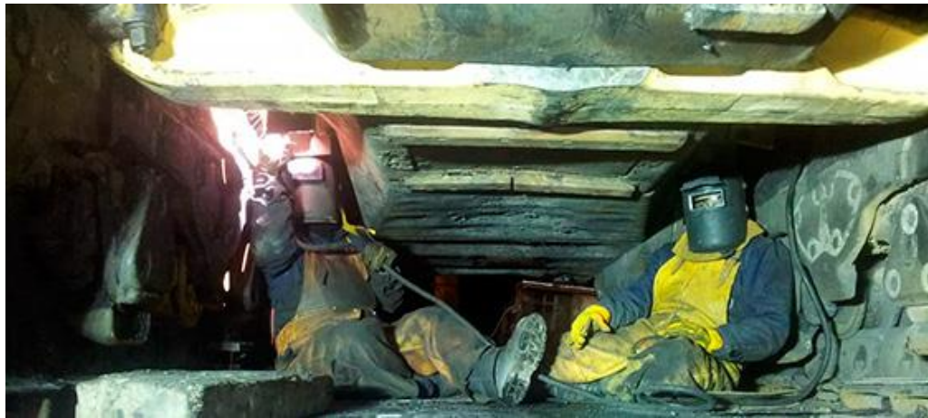
Figura 40. Fisuras por vibraciones
