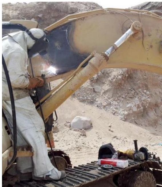
Figura 39. Fisura por fatiga
