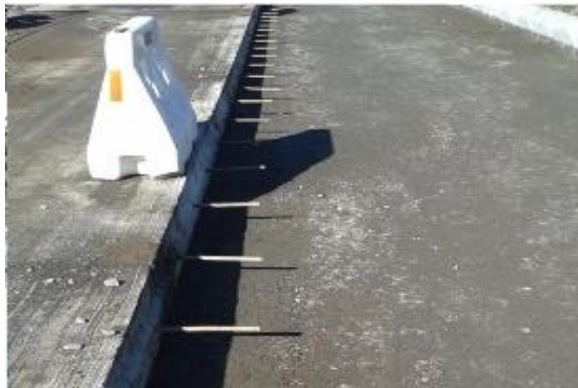
Figura 28. Junta longitudinal de construcción en campo
