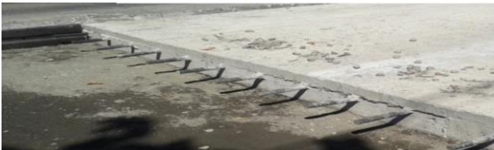
Figura 27. Junta transversal de construcción en campo
