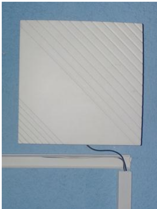
Figura 63. Instalación de alarma sonora
