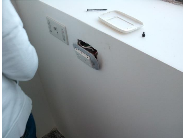
Figura 123. Instalación tomacorrientes sobre tablayeso
