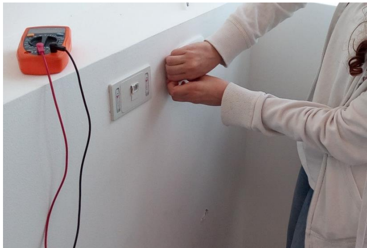
Figura 124. Medición de continuidad en cada tomacorriente
