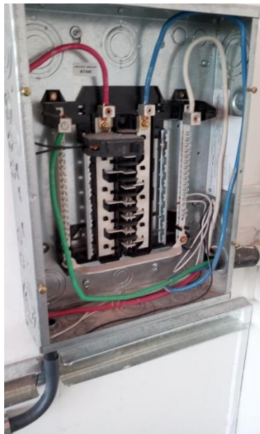
Figura 116. Instalación del tablero de flipones para la nueva instalación
