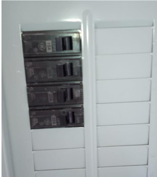
Figura 129. Caja de flipones después de la instalación
