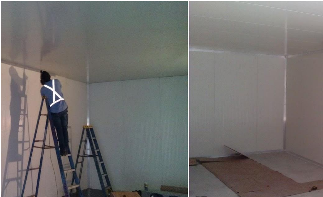
Figura 25. Instalación de angulares
