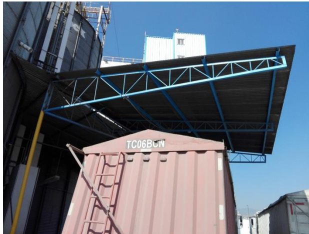
Figura 22. Señalizaciones de ambientes y equipos de seguridad área de descarga de trigo
