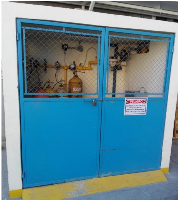
Figura 29. Descarga de gas cloro
