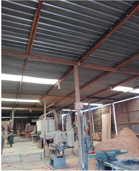
Figura 39. Techo industrial de una sola agua
