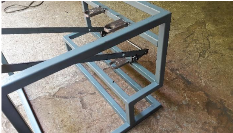
Figura 46. Fabricación de estructura
