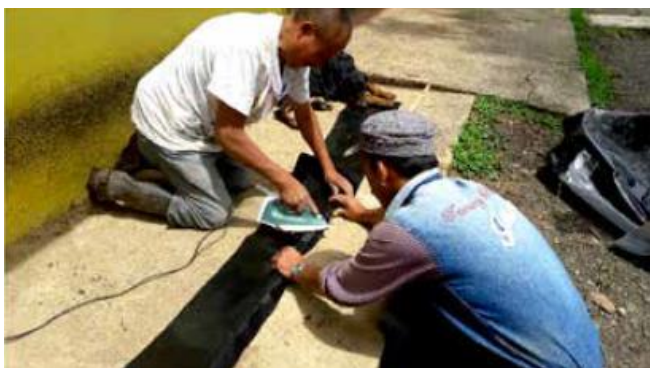
Figura 22. Método de sellado actual
