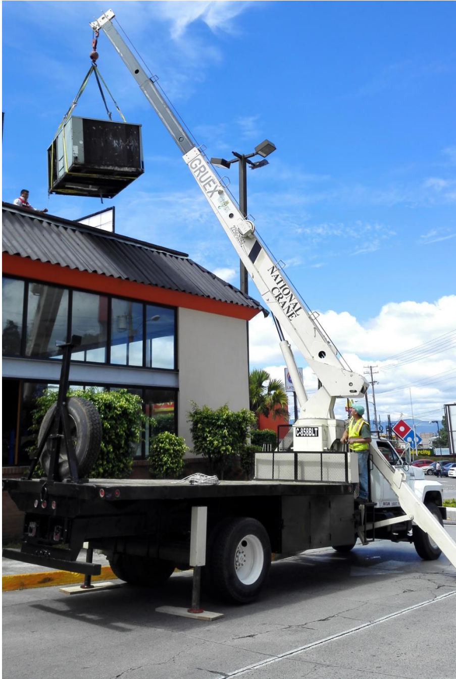
Figura 14. Servicio de instalación
