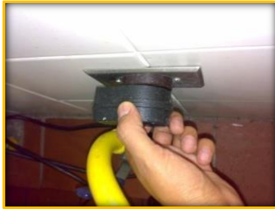
Figura 12. Desenergizar la freidora
