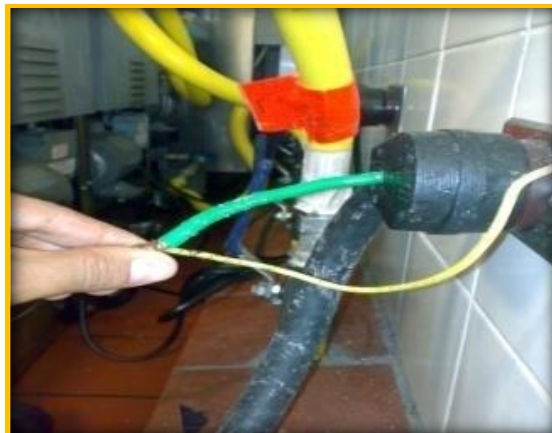
Figura 13. Desconexión de tierra física
