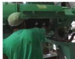
Fig. 17. Proceso de limpieza de la entrada de vapor.
