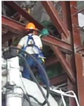
Fig. 6. Colaborador realiza la limpieza con el EPP necesario.
