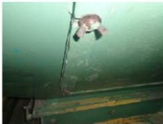
Fig. 3. Tornillos de la compuerta trasera de la enfriadora.
