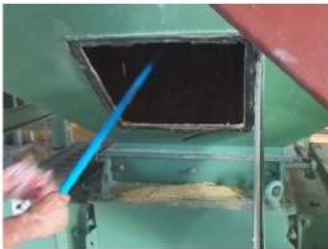
Fig. 4. Limpieza de la enfriadora de forma interna.
