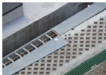
Figura 9. Desmontaje de equipos
