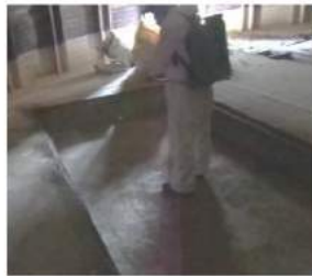
Fig. 6. Personal de sanitización aplicando plaguicida en el conducto de ventilación.
