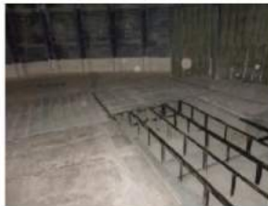
Fig. 7. Colocar la estructura metálica y las láminas en el conducto de ventilación.
