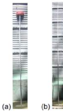
Fig. 2. Personal de sanitización barre las paredes (a) mediante una escoba larga (b) y un tubo para quitar los grumos de maíz pegado en las paredes.
