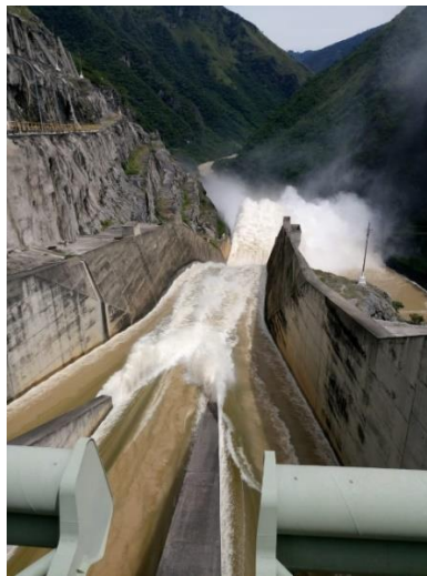
Figura 7. Vertedero de demasía en Hidroeléctrica Chixoy
