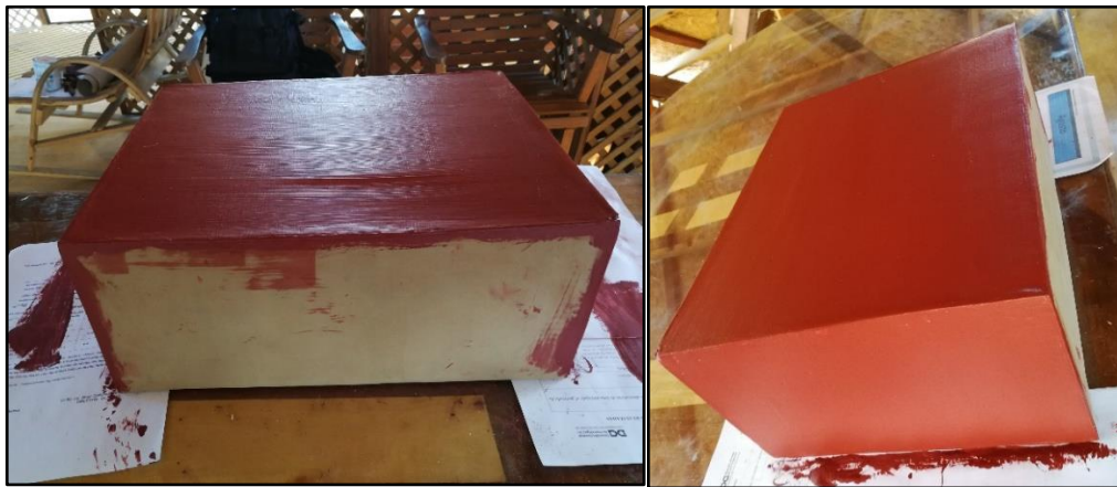
Figura 27. Aplicación de impermeabilizante al prisma rectangular
