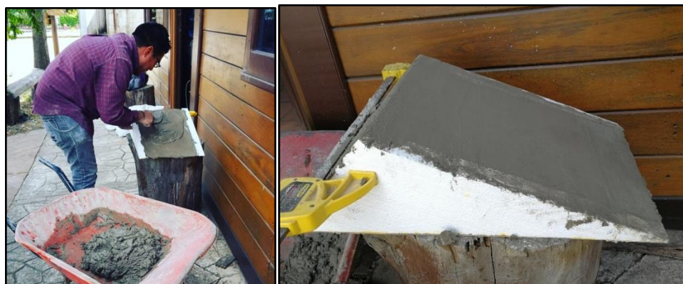
Figura 48. Fundición de prisma triangular
