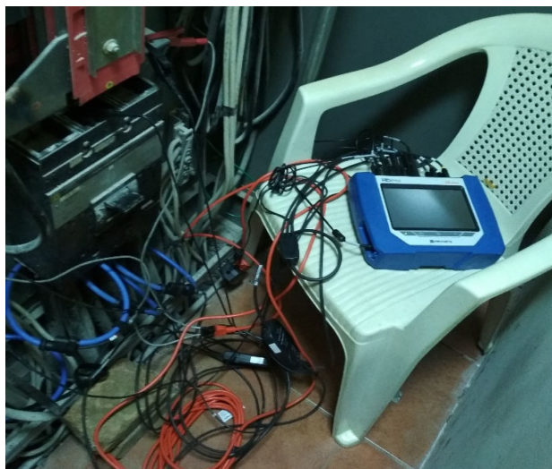
Figura 28. Instalación de Dranetz HDPQ Guide en tablero principal
