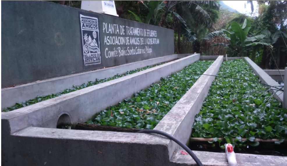
Figura 9. Tanques fitorremediadores del tratamiento terciario en la planta de efluentes de la Asociación Amigos del Lago
