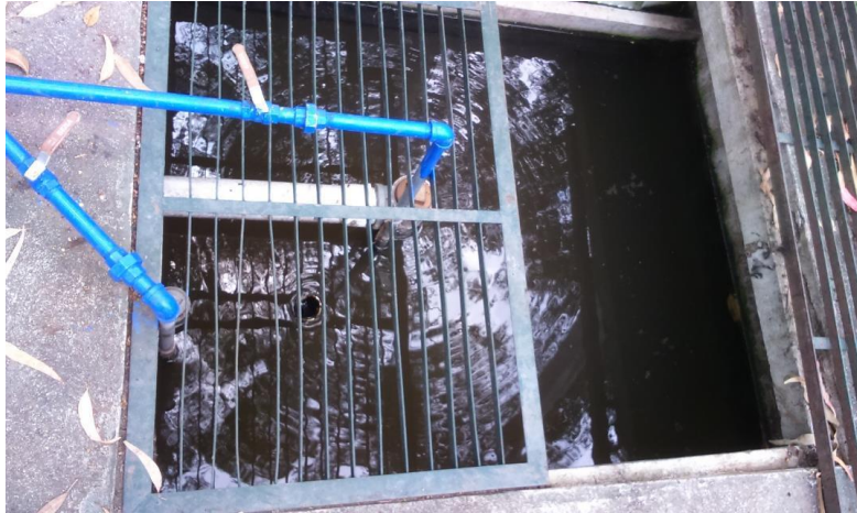
Figura 7. Reactor de aireación del primer tratamiento en la planta de efluentes de la Asociación Amigos del Lago
