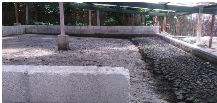
Figura 10. Patio de secado del tratamiento primario de los lodos residuales, en la planta de efluentes de la Asociación Amigos del Lago
