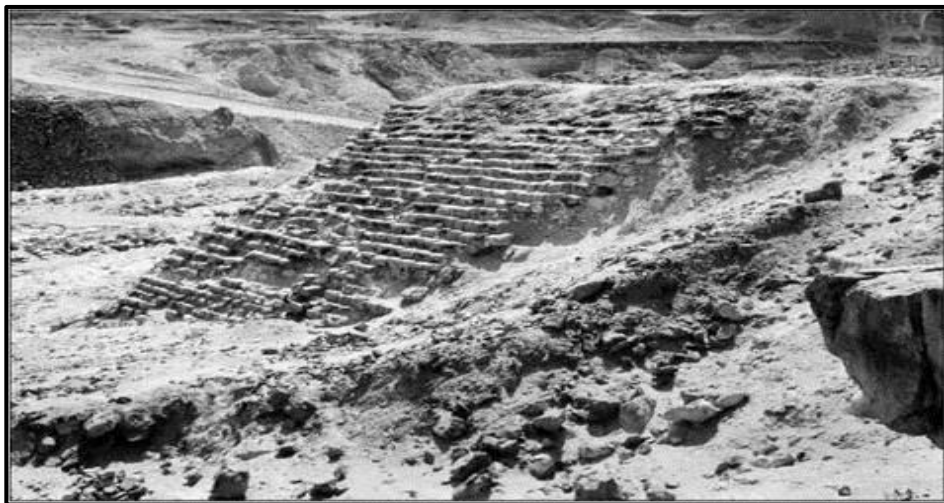
Figura 3. Presa de Sad El-Kafara, Egipto
