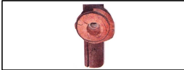
Figura 7. Tubería de madera de Manhattan de finales de siglo XIX
