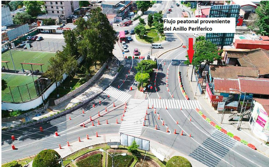
Figura 27. Implementación de 5 baldosas para flujo peatonal proveniente del Anillo Periférico
