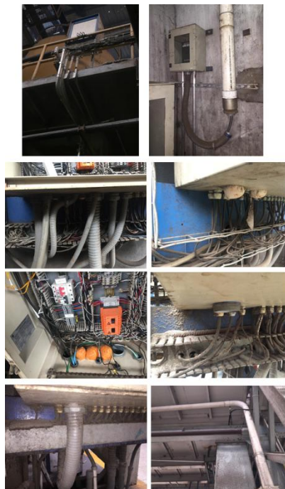
Figura 140. Distribución del cable en las instalaciones
