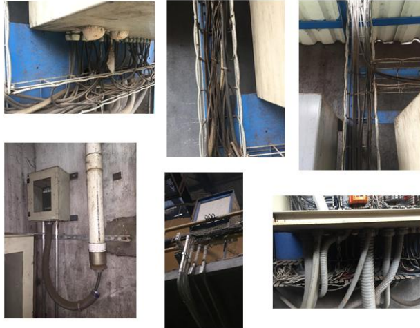
Figura 92. Instalación de fibra óptica en ductos, bandejas y tuberías
