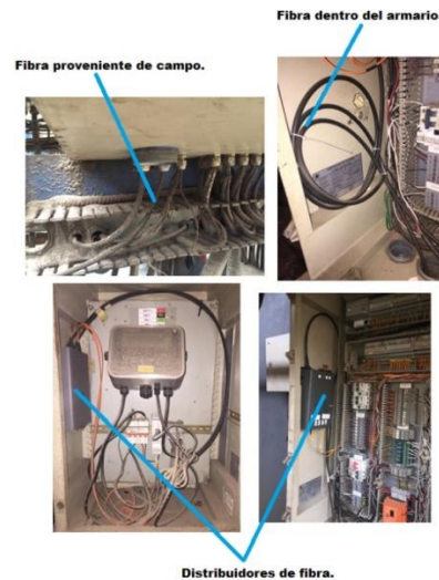
Figura 89. Instalación excedente de fibra óptica
