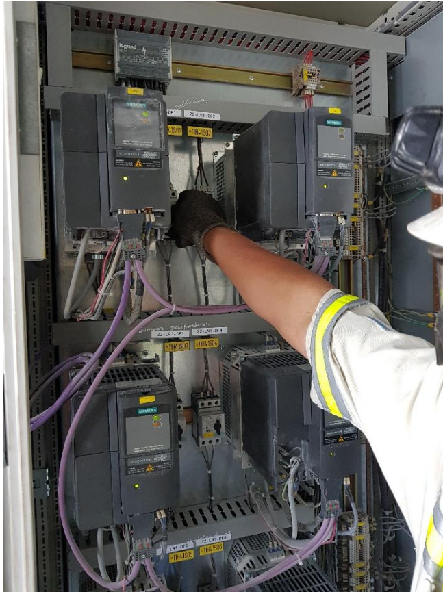
Figura 75. Pruebas de bloqueo en paneles eléctricos
