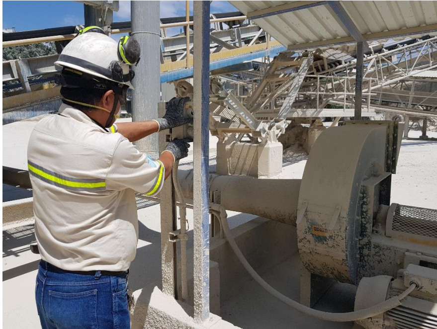
Figura 76. Pruebas de bloqueo en campo
