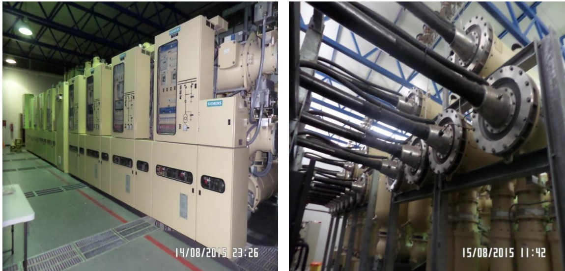
Figura 36. Módulo GIS, 8DN9
