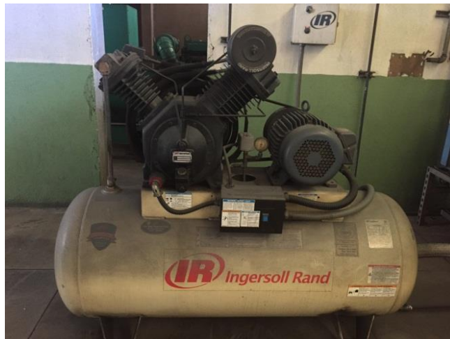
Figura 17. Compresor de pistón
