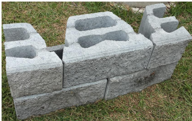
Figura 13. Vista expuesta del muro
