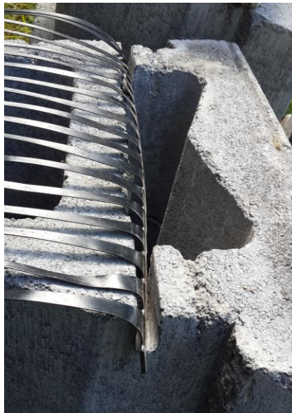
Figura 27. Colocación refuerzo en modificación
