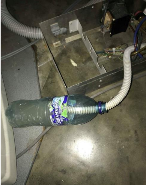
Figuras 18 y 19. Como se encontraba antes la succión de la unidad dental.
