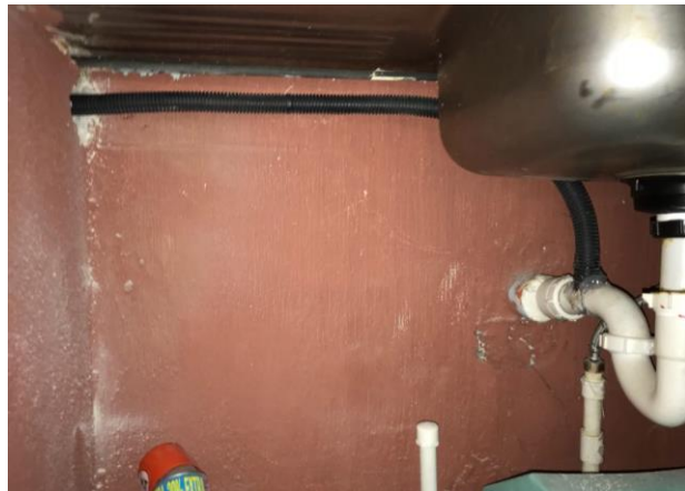
Figuras 20 y 21. Una vez realizada la instalación directa de la succión al drenaje.
