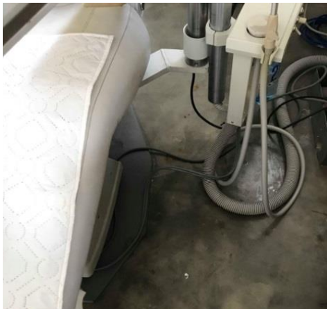
Figuras 20 y 21. Una vez realizada la instalación directa de la succión al drenaje.
