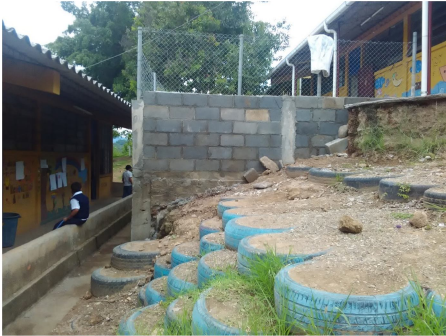
Relleno con tierra de la parte superior del patio ya con el muro finalizado
