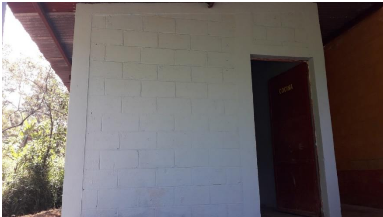
Figura No. 2. Vista final del proyecto
