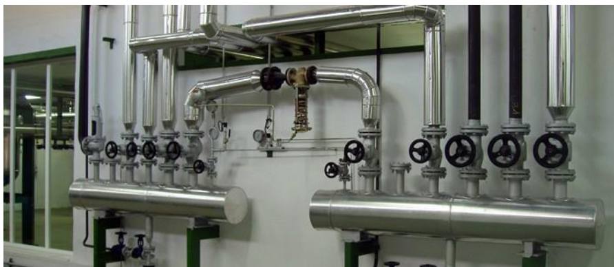
Figura 3. Red de distribución y colector de vapor
