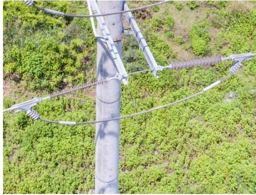
Figura 150. Engrapado en aisladores de remate
