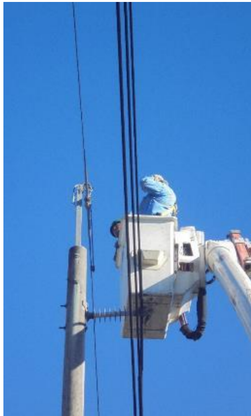
Figura 149. Engrapado de OPGW en configuración tangente
