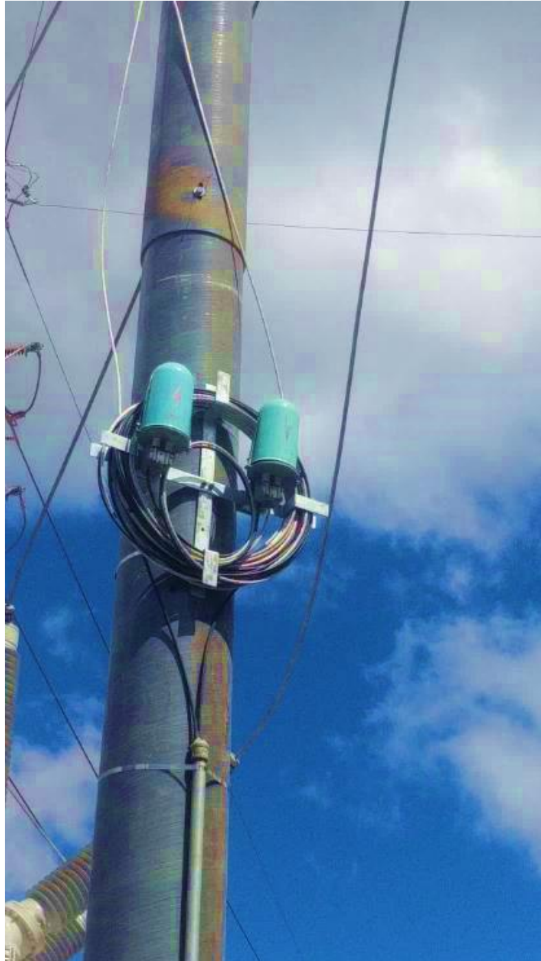
Figura 52. Mufa de fusión de OPGW con reserva
