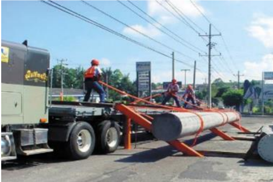
Figura 125. Descarga de secciones de monopolos
