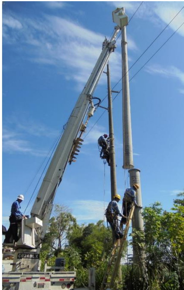
Figura 186. Cambio de poste de concreto
