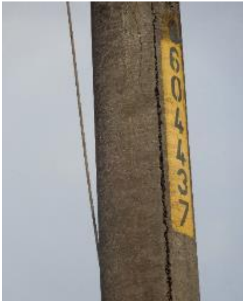
Figura 175. Poste dañado
