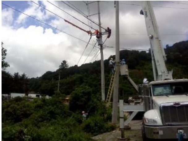
Figura 130. Empalme de flange en postes de concreto
