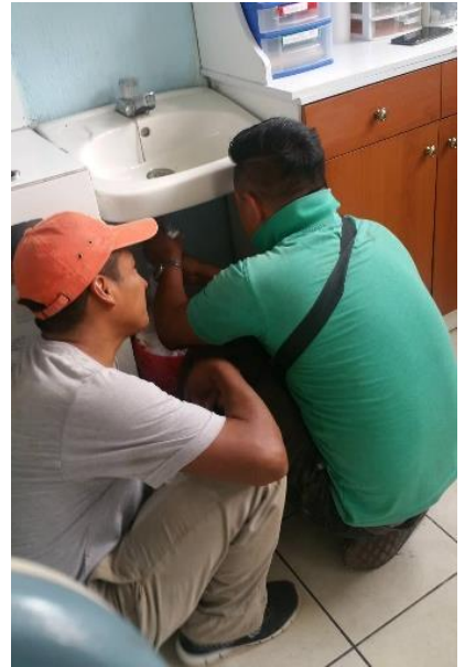
Fotografía núm. 6 Reparación de lavamanos.
