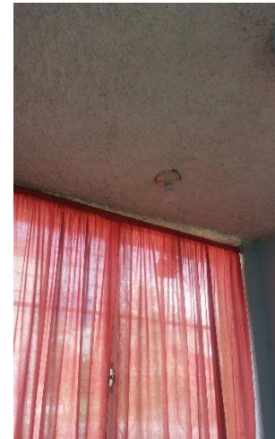
Fotografía núm. 8 Colocación de focos de luz.
