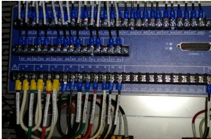
Figura 55. Bornes de corrientes y voltajes para un relé SEL-311L
