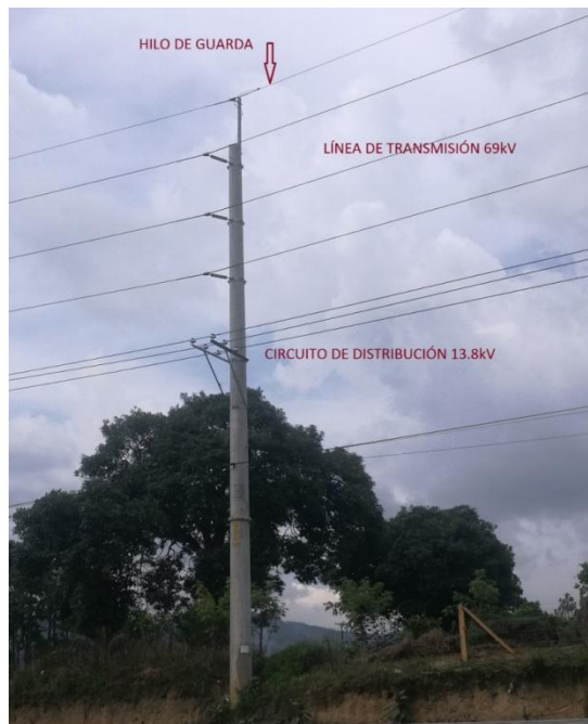
Figura 5. Posición de instalación del hilo de guarda
